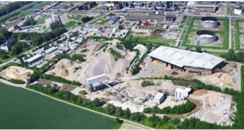
Bauschuttrecyclinganlage der BAVAK im Karlsruher Rheinshafen
