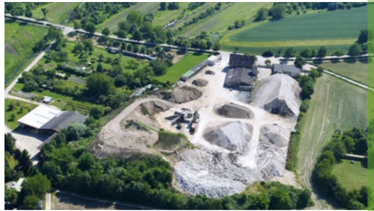
Bauschuttrecyclinganlage Stutz am Standort Eggenstein-Leopoldshafen
