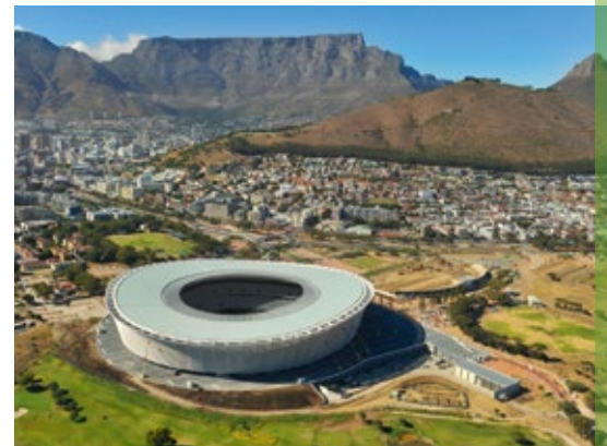
Bewegliches Dach des WM-Stadions in Kapstadt mit SEW-Antriebstechnik
