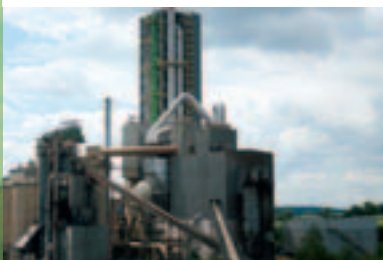
Zementwerk Wössingen © Lafarge
