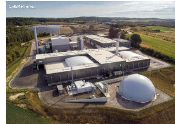
AVR BioTerra in Sinsheim: hier wird ein Teil der Bioabfälle aus dem Landkreis Karlsruhe verarbeitet
